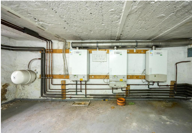
KG: Gas-Etagenheizungen
