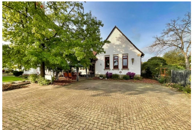
Straßenansicht - großzügiger Parkplatz
