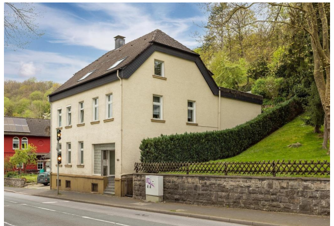
Außenansicht, rechts oben
