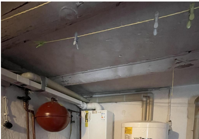
Heizungsanlage Gas-Brennwert
